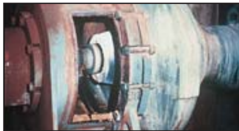
Internal Cartridge GPAC Ingersoll-Dresser Pump. (Canada) Alcan (Canada).
